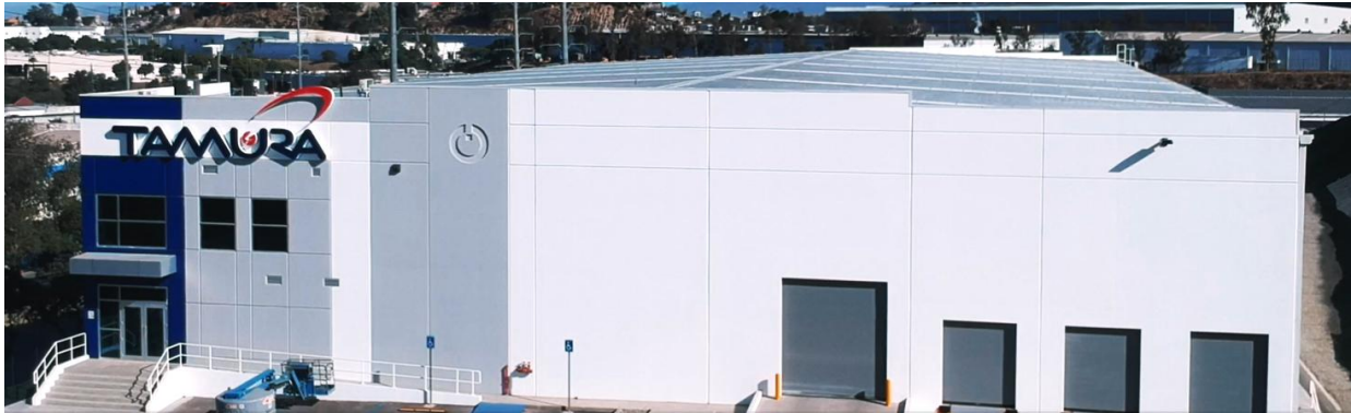
Tamura Power Technologies de Mexico SA, DEC. V. 第2工場 （設備投資金額約100万USD、建屋レンタル費用約50万USD/年、延べ床面積：約4000㎡）
